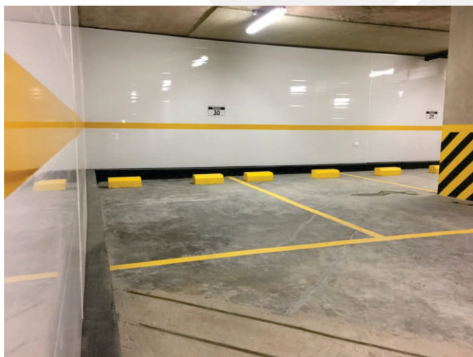
ECOTOWER 93 TECNOLOGIA INMOBILIARIA AREA APROXIMADA 900 M2
